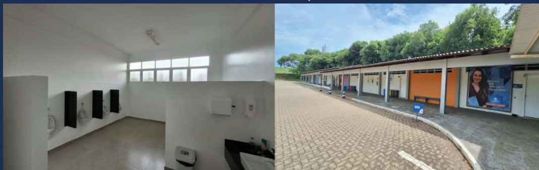
Reformas nos banheiros e pintura externa
